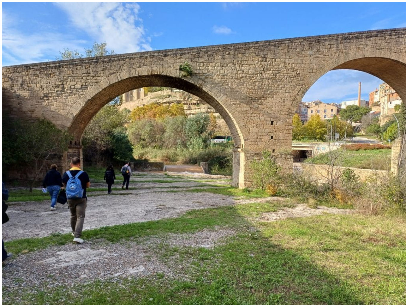
le pont du Cardener
